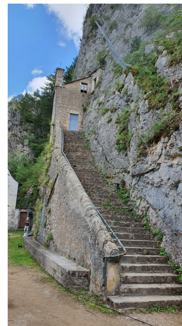
L'escalier de l'Ermitage de Saint-Privat
